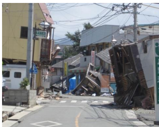
損壊建物（地震）
