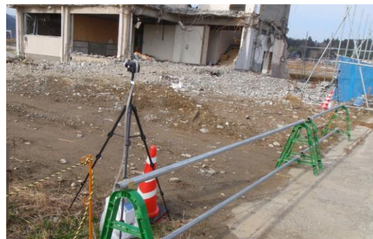
損壊建築物近傍での測定例
