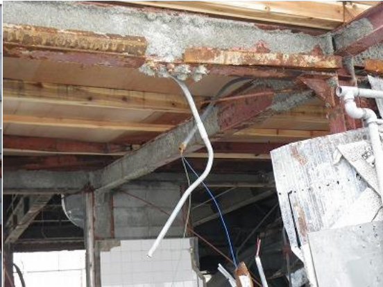
残存した吹付け材
