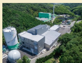
縦型乾式メタン発酵施設
