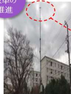
5G基地局/ 港南台住宅 (写真提供元：関東財務局)
