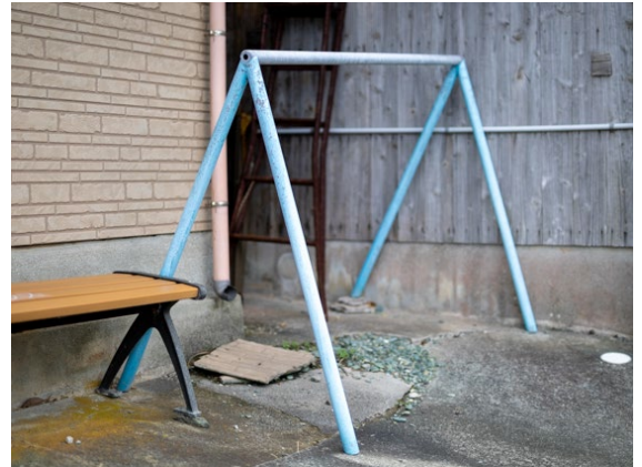
■近年急増しているサイクリング客用にサイクルラックも完備
