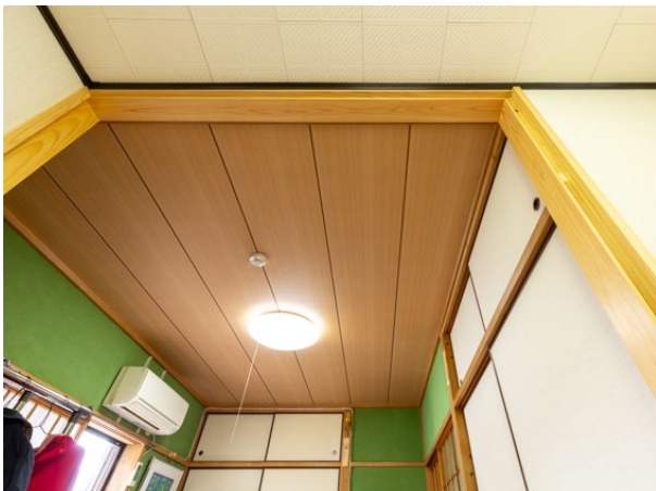
■もともとあった引き戸や鴨居を取り除き、開放的な空間に改装
