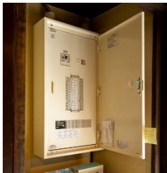
■分電盤をはじめ電気設備や空調設備を整備
