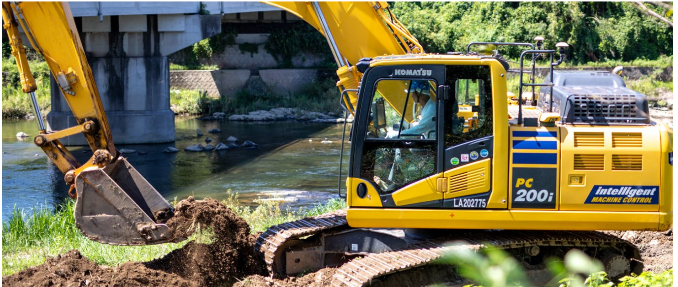
■最新式の測量機械とソフトの導入により、ICT 活用が要件となっている工事も受注できるようになった
