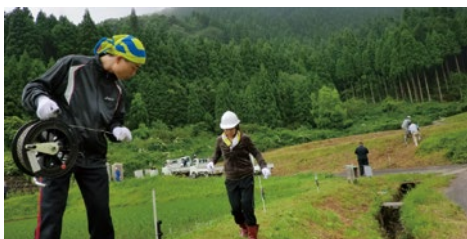
ボランティア活動によるいのしし電気柵の設置
