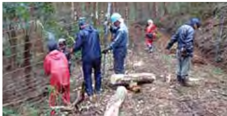
鳥獣被害防止柵設置の様子
