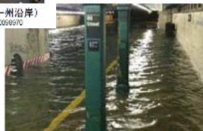
地下鉄の浸水状況（86ストリート駅） 「米国ハリケーン・サンディに関する国土交通省・防災関連学会合同調査団による緊急メッセージ（平成25年10月9日）」
