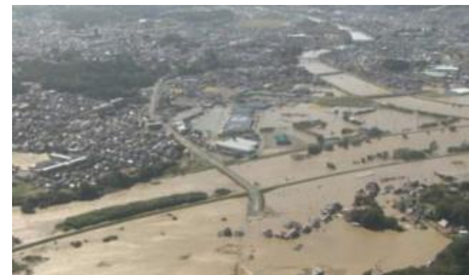
阿武隈川堤防決壊による浸水状況(福島県)
