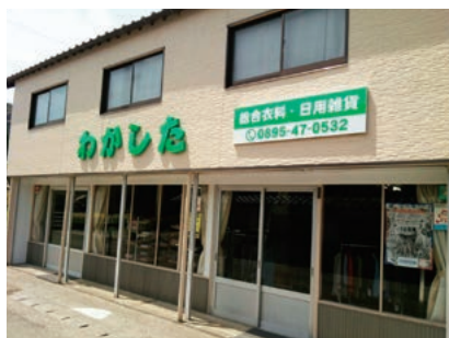
新設した店舗
