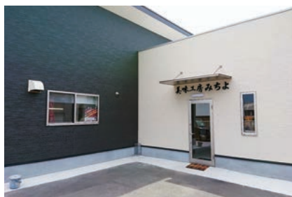
新設した店舗
